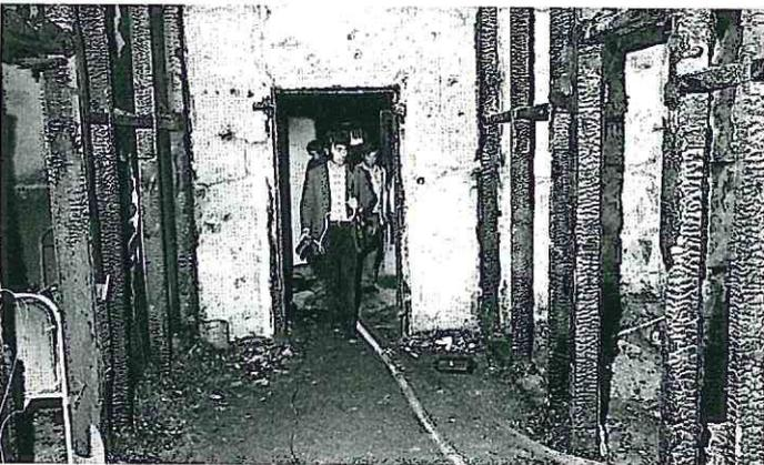
**Bilder des Schreckens und der Verwüstung.** Die Figuren des Kicker-Spiels auf dem oberen Bild sind von der Hitze geschmolzen. Auf dem Bild unten links ist deutlich die Holzkonstruktion der Wände zu erkennen, die dem Feuer so reichlich Nahrung gab.
